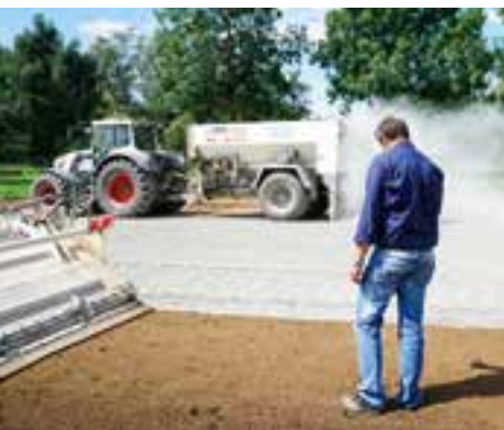
Bei solchen Bodenstabilisierungsarbeiten ist Spurführung unverzichtbar.
