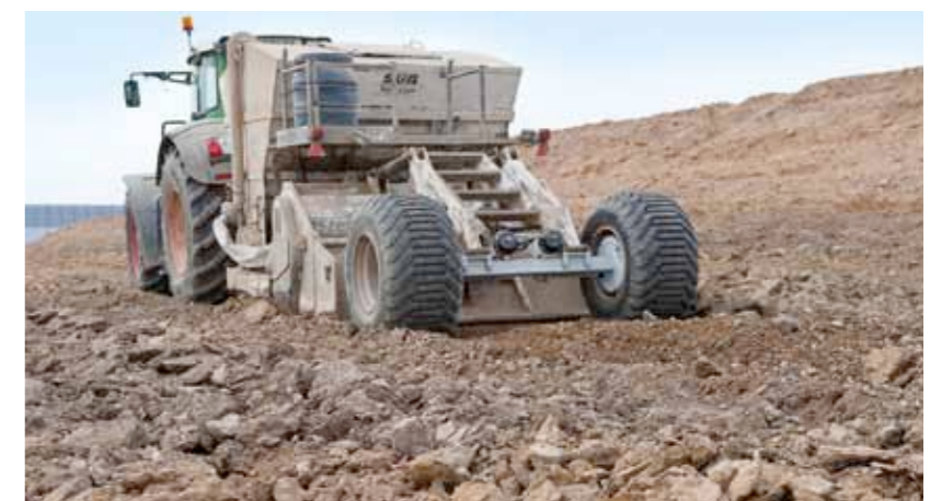
Fendt 930 Vario mit einer SBF 24-6 Fräse: Der Mischbinder wird nach Bodenarten sowie Feuchtigkeitsklasse bestimmt, z. B. B50 entspricht 50 % Kalk- und 50 % Zementanteil (Foto: Daniela Müller)
