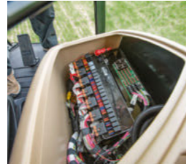
■ Kergesti juurdepääsetav tsentraalne elektrisüsteemi lülituskeskus koos FENDIAS diagnostikahendustega
